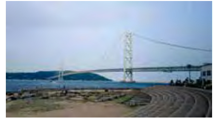
明石海峡大橋(神戸市)
