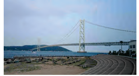
明石海峡大橋(神戸市)
